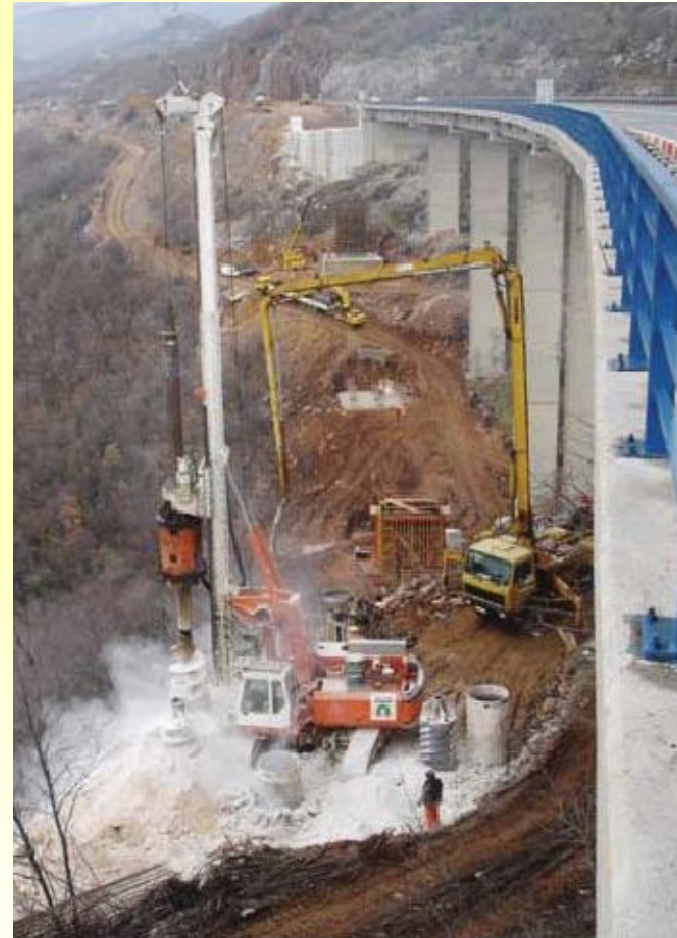
Zakládání opěry nového mostu
