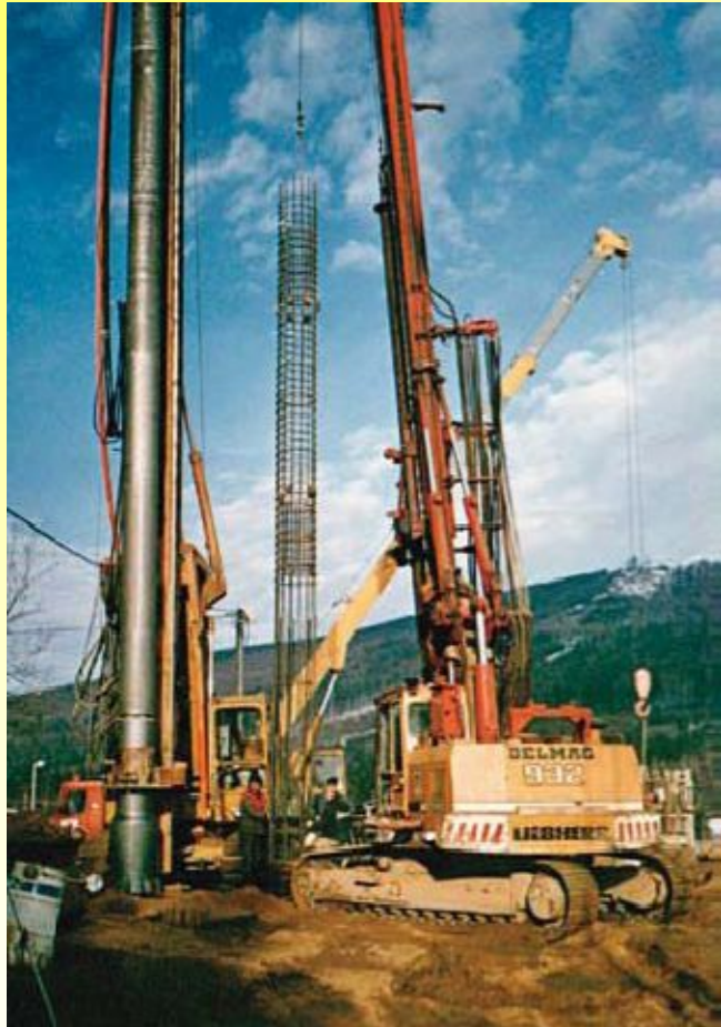
Vkládání armokoše do vrtu
