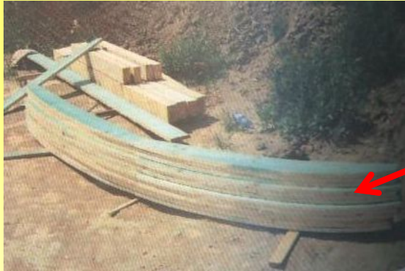
Ramenáty připravené k montáži
