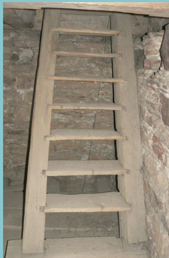
SCHODIŠTĚ DO ZVONICE
