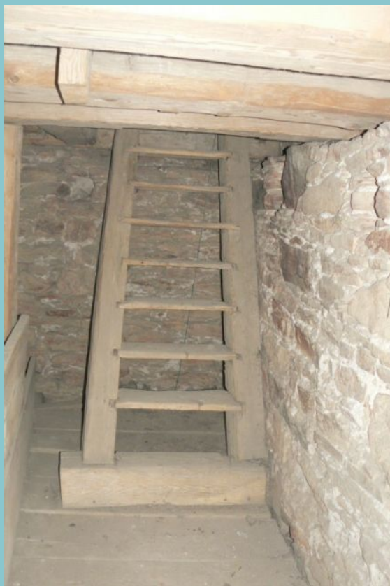
LÁVKA A SCHODIŠTĚ
